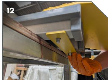
Legen Sie die kleine Stahlstützplatte von unten über die 3 Schrauben und ziehen Sie sie mithilfe von 3 x M10 Nylocmutter fingerfest an.
