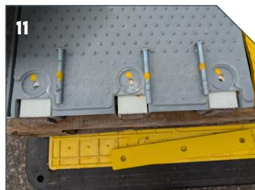
Die Schrauben hierfür sind, wie im Bild oben zu sehen, gelb markiert. Verwenden Sie ausschließlich diese Schrauben.
