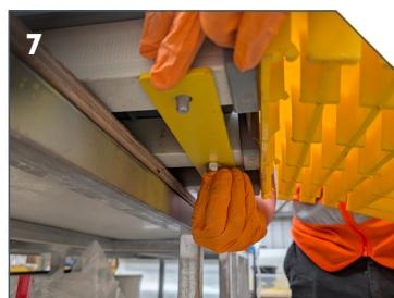
Legen Sie die kleine Stahlstützplatte von unten über die 3 Schrauben und ziehen Sie sie mithilfe von 3 x M10 Nylocmuttern fingerfest an.
